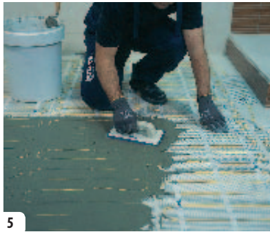
5- Cubrimos totalmente la malla con un recrido, Maxifluid.
