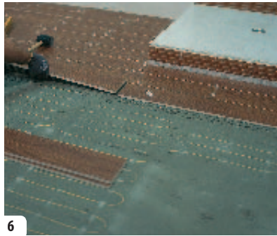
6- Colocamos el material cerámico con Maxifluid asegurando que la malla queda totalmente cubierta.
