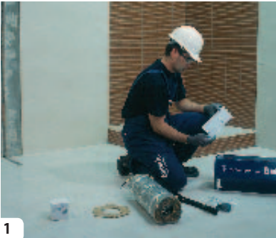
1- Replanteo de la superficie donde se va a colocar la malla.
