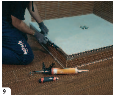
9- Sellamos el plato de ducha con s-502 de forma que queda totalmente aislado.
