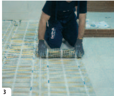
3- Colocación de la malla en el suelo, repartiendola de manera uniforme.
