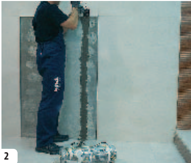
2- Preparación del revestimiento para la instalación de la caja donde se instalará el termostato.
